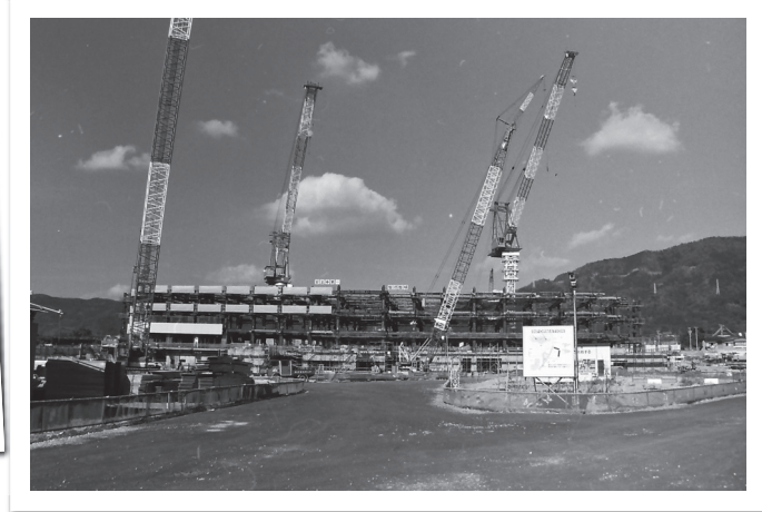
建設中の新市民病院
